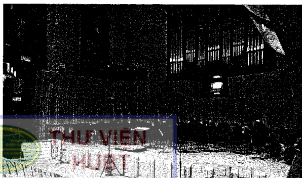
Hình 2.30. Tường xung quanh sân khấu với bề mặt khếch tán và phần trên của tường sân khấu được nghiêng xuống tại khán phòng trường Đại học Nghệ thuật quốc gia Đà Bắc
